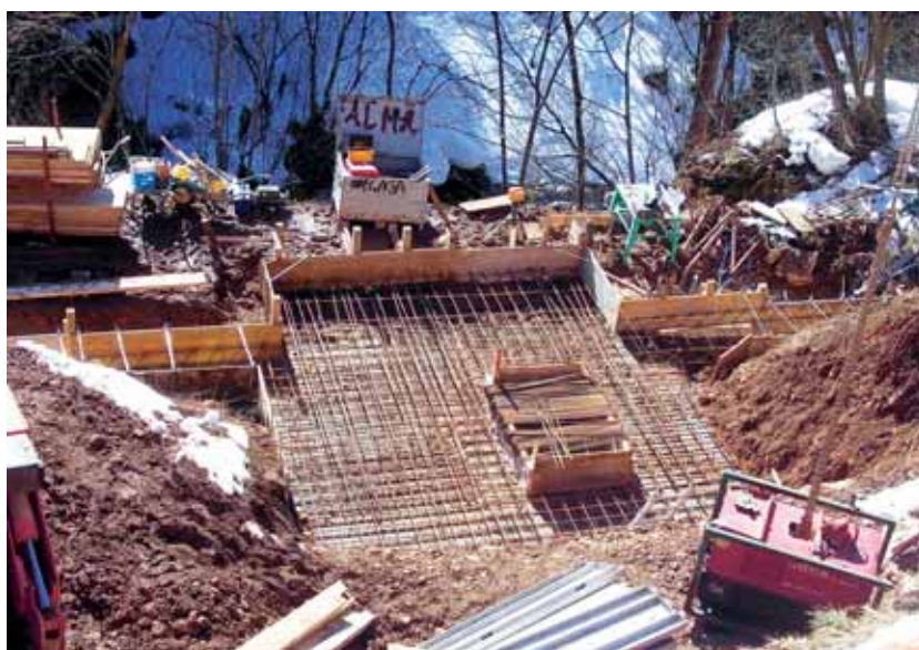
Le fondamenta della centralina idroelettrica (foto Sws Engineering).
