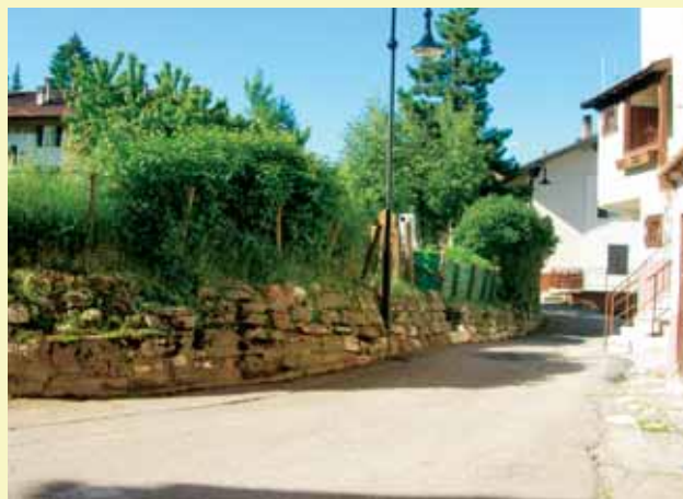
Via Schirni prima dei lavori.
