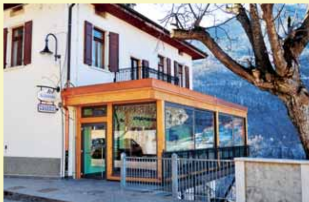
Il nuovo aspetto del centro multiservizi.
