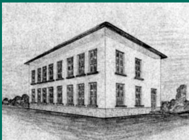
LA SCUOLA ELEMENTARE DI NOSELLARI PRIMA DELLA SOPRAELEVAZIONE
