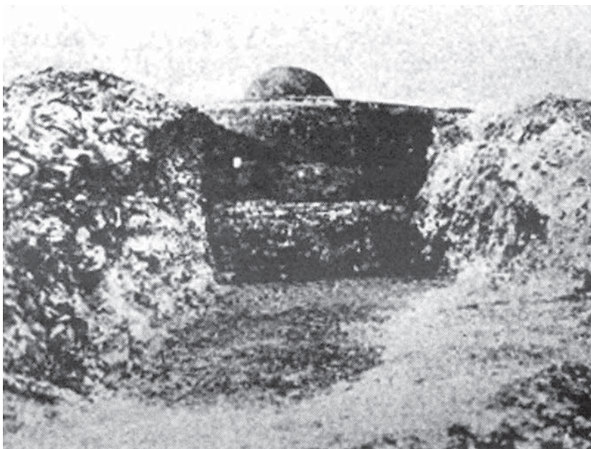
La parete messa allo scoperto per la prova.
