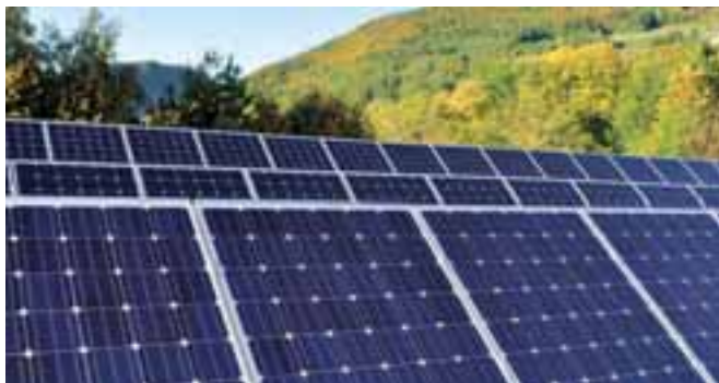
Pannelli fotovoltaici sul depuratore.
