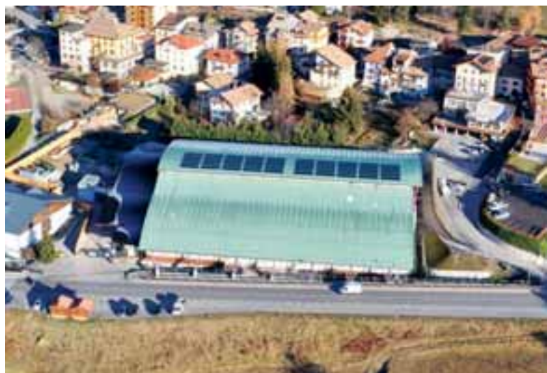
I pannelli fotovoltaici in una vista del Palaghiaccio dall'elicottero.
