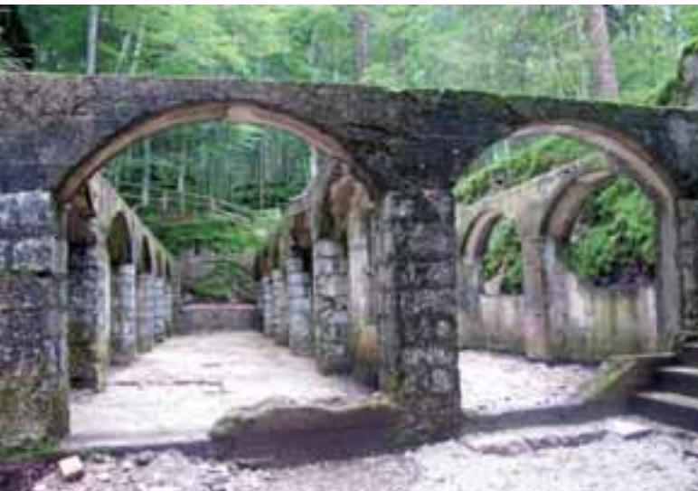
Lavori di recupero del Comando di Virti.
